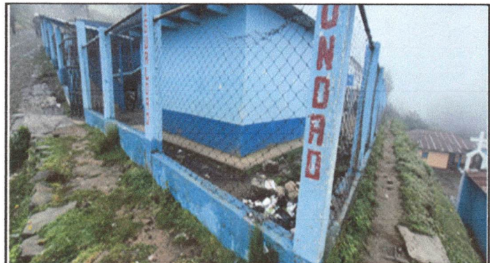
Foto 4: REPARACION DE PINTURAS EN MUROS EXTERIORES.
