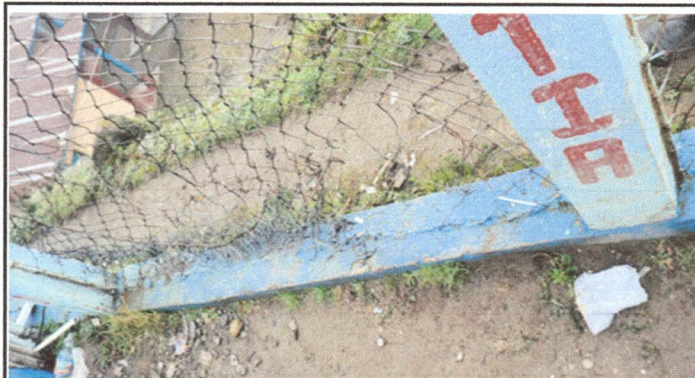
Foto 3: REPARACION DE MUROS PERIMETRALES
