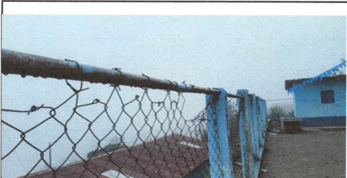
Foto 5: REPARACION DE MUROS PERIMETRALES
