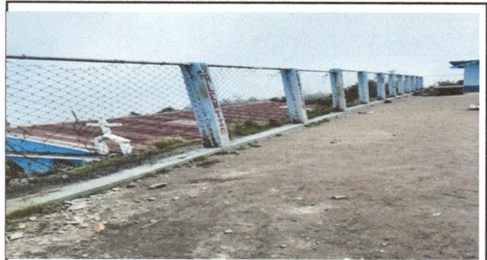
Foto 2: SUSTITUCION DE PISO DE TORTA DE CONCRETO
